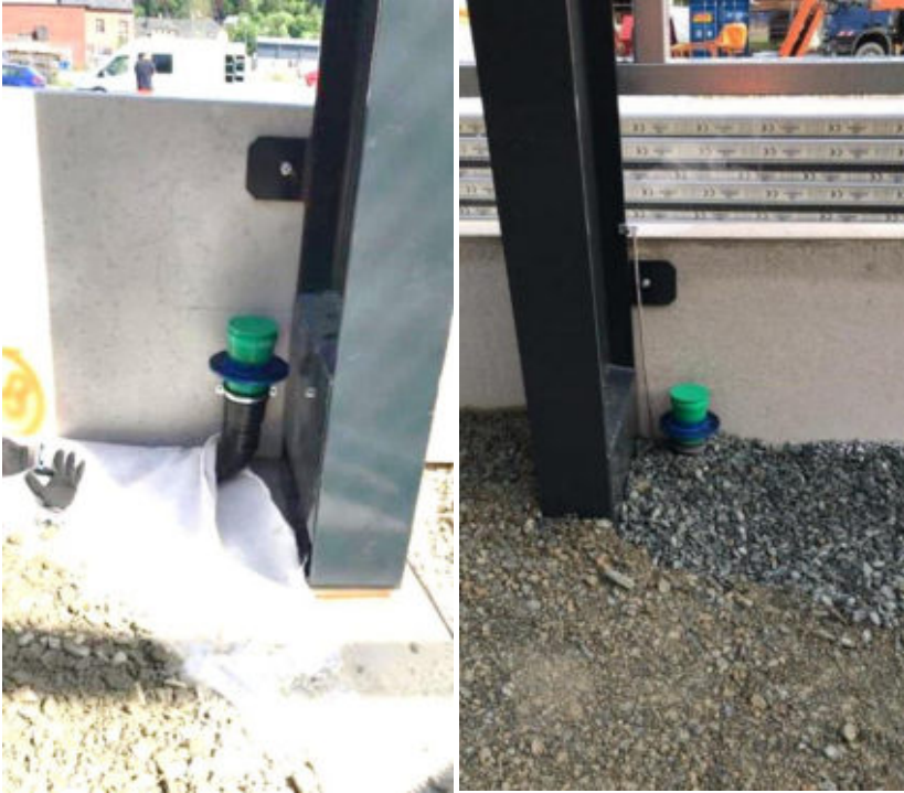
Abbildung 15 und 16: Steigrohr der Dränage neben dem Stützenfuß
