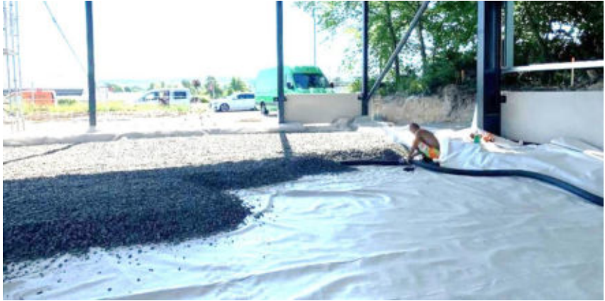
Abbildung 14: Einbau der Dränageschicht (Quelle: List Bau München)
