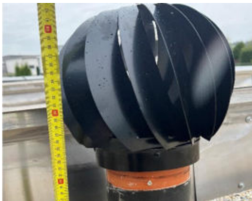
Abbildung 6: Nachträgliche Installation einer Wind-Rotationshaube
