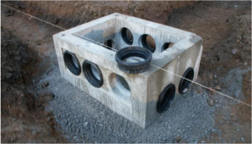
Abbildung 8: Bodentank als Stahlbetonfertigteile mit Ringraumdichtungen zur Rohreinführung
