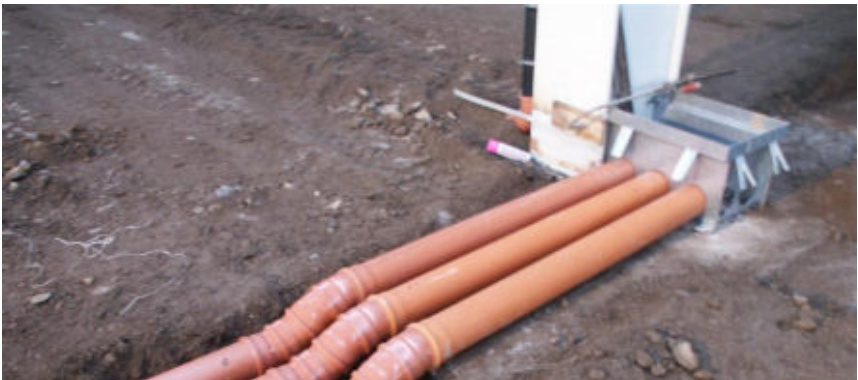
Abbildung 9: Bodentank aus Stahlblech im Bereich der Haupttragstützen
